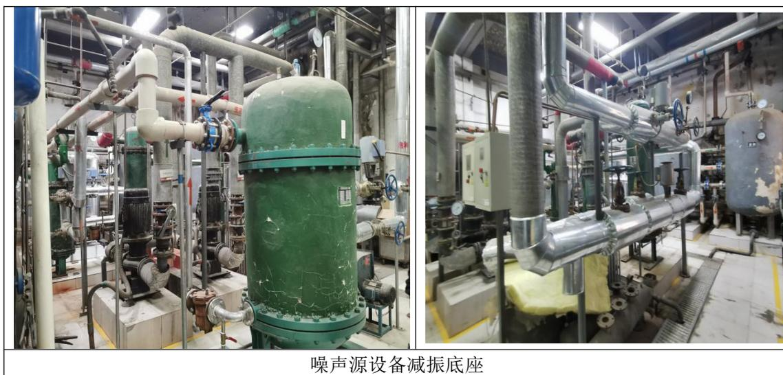
图 4.1-4 噪声源设备减振底座
